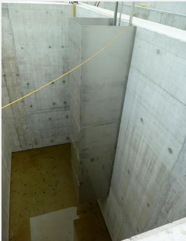
Fig. 6 Einlauf-Tauchkasten in der unbelüfteten Zone der ARA Höfe für Zusammenführung von Zulauf und Rücklaufschlamm. Einlauf und Rücklaufschlammleitung durch Kasten verdeckt.
