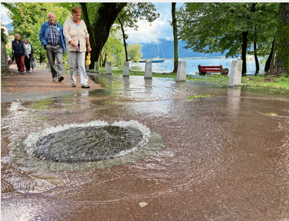
Fig. 2 Wet-Spot : Schacht mit Wasseraustritt nach einem Starkregenereignis.
