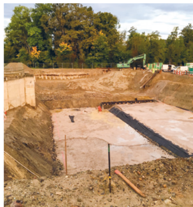
Im Vordergrund ist der Aushub für die dritte Biologiestrasse zu sehen, im Hintergrund wird der Aushub für die Elimination der Mikroverunreinigungen realisiert.
