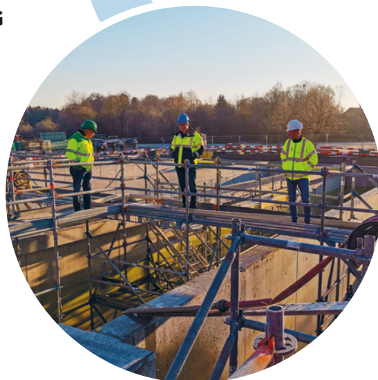
Die Firma Vetter leistete hervorragende Aushub- und Baumeisterarbeiten.
