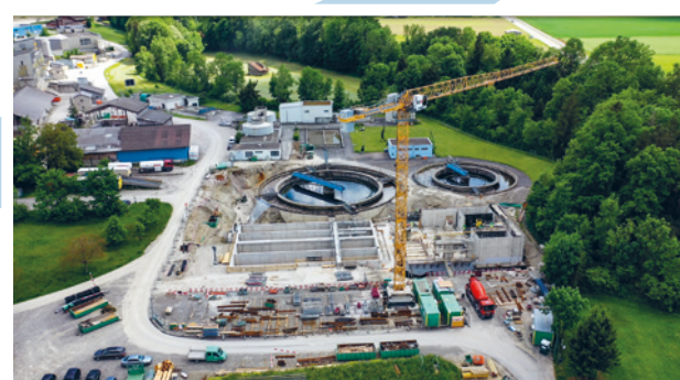
Für die umfangreiche Baustelle waren die Platzverhältnisse ausreichend.
