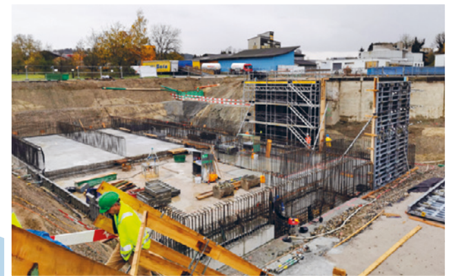
Auch während der intensivsten und heftigsten Corona-phasen ist der Baustellenbetrieb weitergelaufen.
