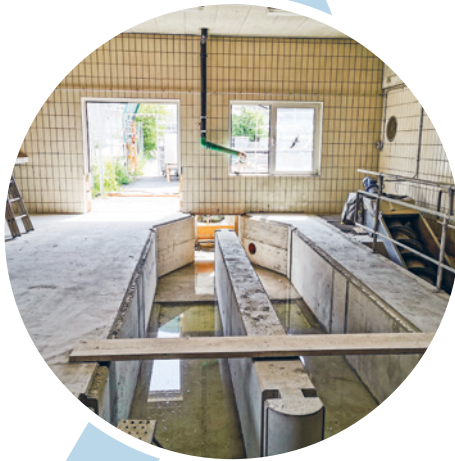
Sanierung der zweistrassigen Rechenanlage.
